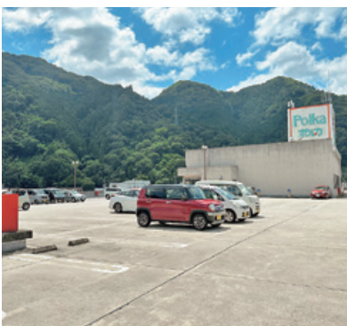
ポルカ屋上駐車場
